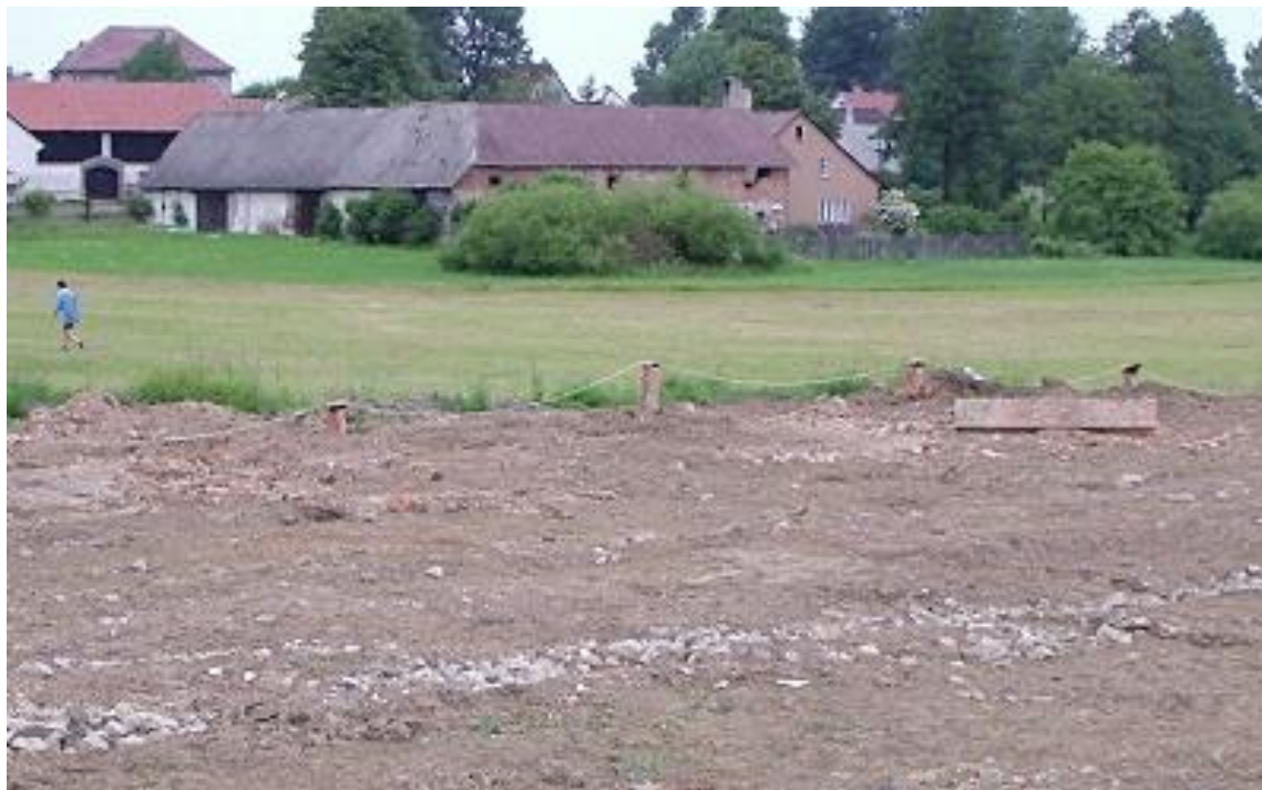
Obrázek 41 2004 Patky na oplocení jsou v zemi
